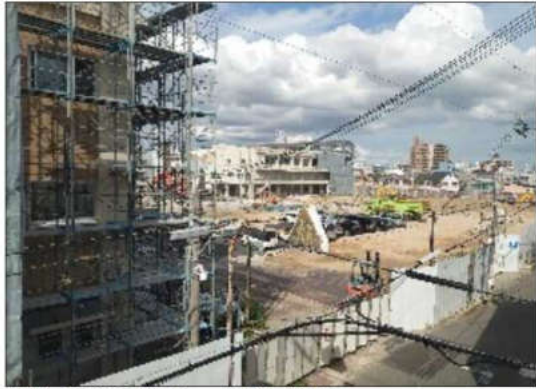
解体工事の始まった6中敷地
